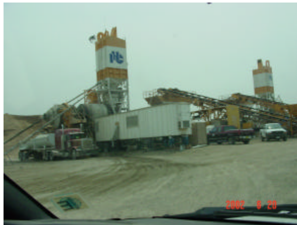
Figura 6.1 – Distribución habitual de una planta de concreto
