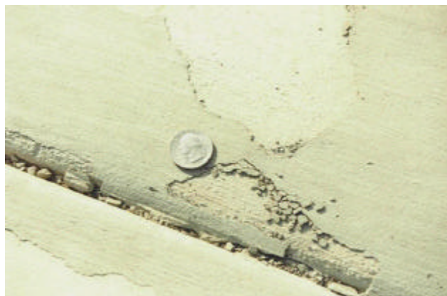
Figura 11.2 – Desprendimientos superficiales debidos a una reparación de asentamiento de borde inapropiada
