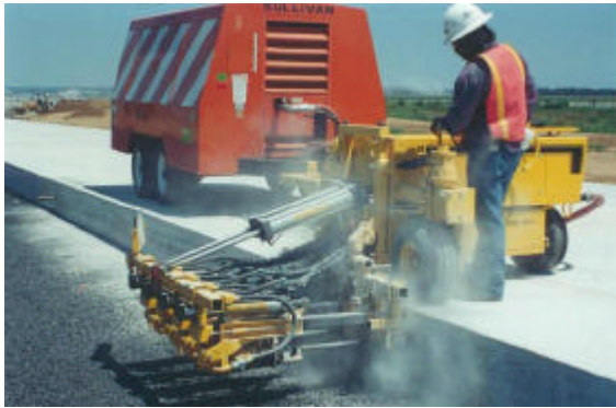
Figura 8.4 – Instalación de pasadores a lo largo de una junta de construcción longitudinal
