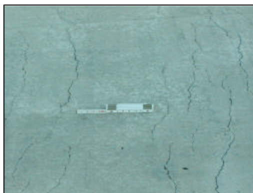
Figura 11.1 – Agrietamiento por retracción plástica
