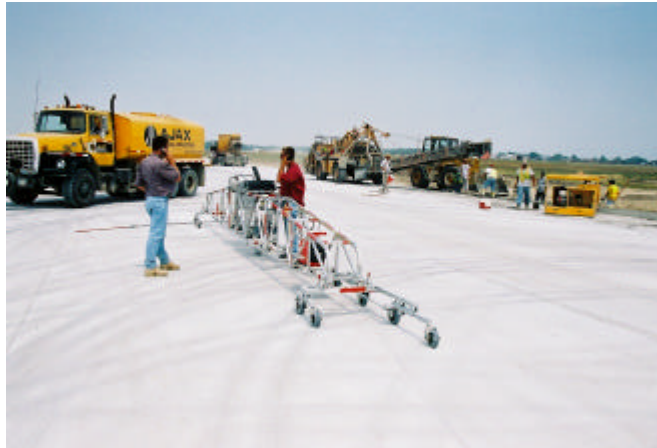
Figura 10.4 – Ensayo en curso con perfilógrafo
