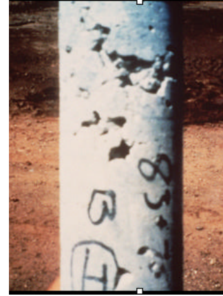
Figura 8.6 – Concreto con “nidos de abeja”
