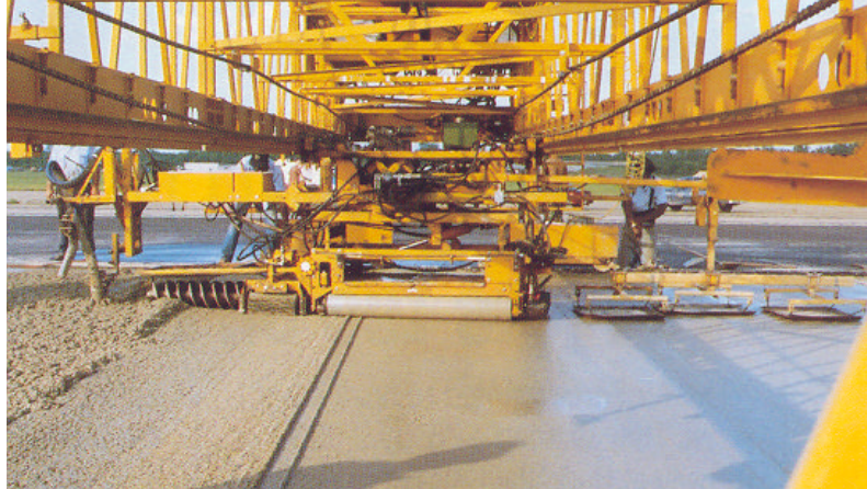
Figura 8.1 – Operación típica de una pavimentadora de tablero de puente
