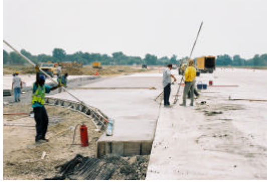
Figura 8.2 – Una construcción típica de una curva de enlace
