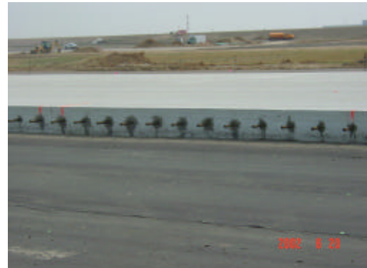
Figura 8.4 – Instalación de pasadores a lo largo de una junta de construcción longitudinal
