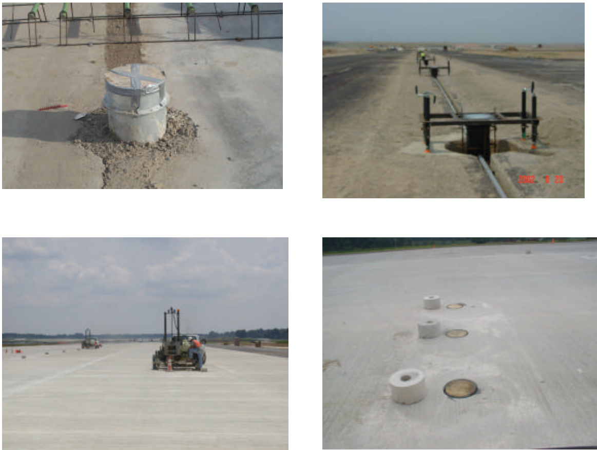
Figura 8.10 - Técnica de extracción de testigos para caja en dos partes
