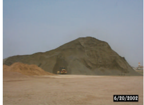
Figura 6.3 – Un acopio excesivamente alto
