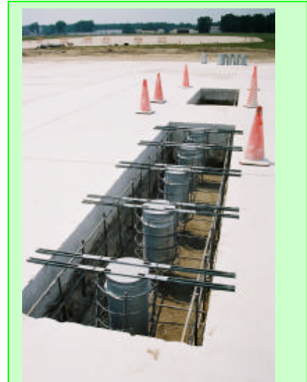
Figura 8.9 – Método con moldes de exclusión
